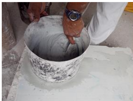
Figura 12 - Preparação da cola de gesso manualmente, sem o uso de agitador mecânico
