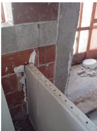
Figura 11 - 1ª fiada iniciando sem o contato com a superfície chapiscada da alvenaria de periferia
