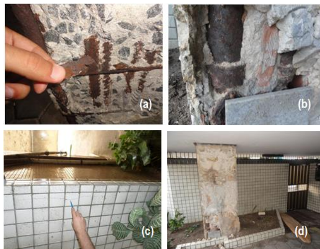
Figura 3 – Inspeção visual do térreo
