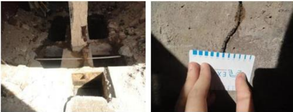
Figura 7 – Inspeção visual do Bloco de Fundação do Pilar PE
