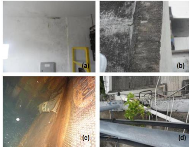
Figura 4 – Inspeção visual das áreas de reservatórios e cobertura
