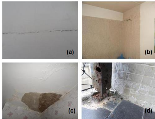
Figura 5 – Inspeção visual dos apartamentos
