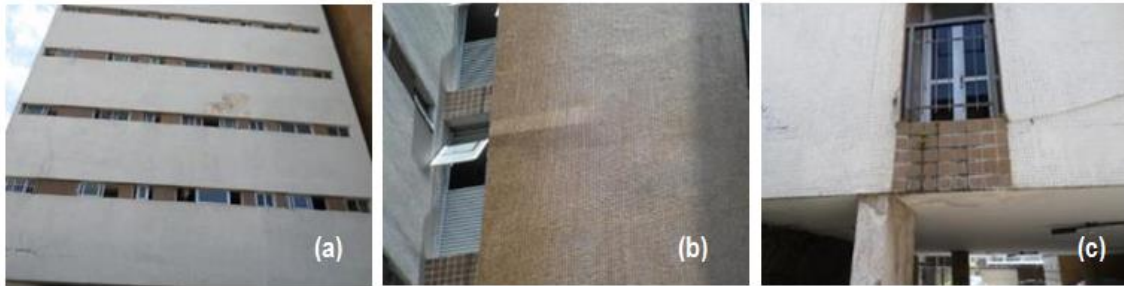
Figura 8 – Inspeção visual das fachadas
