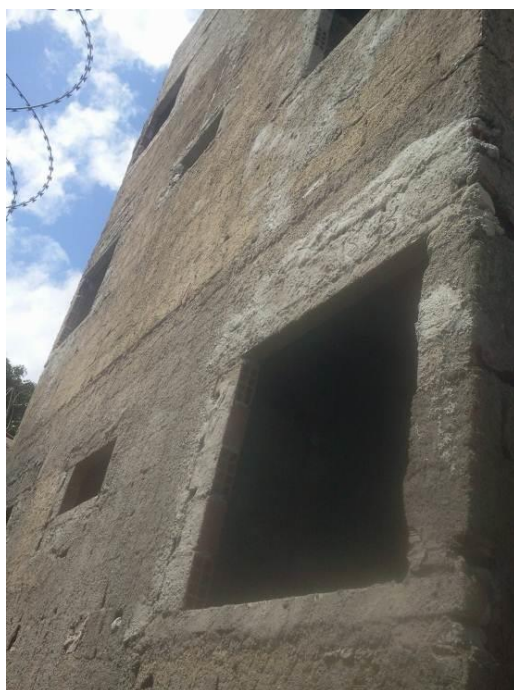
Figura 10 – Fachada lavada e chapiscada
