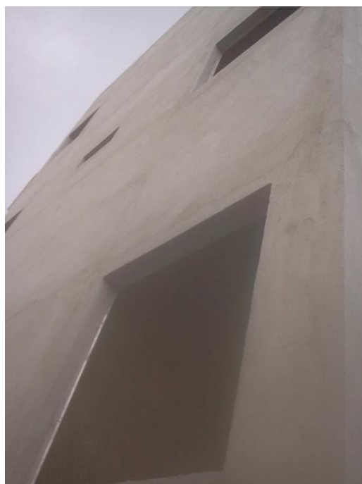
Figura 13 – Fachada com contramarcos e revestimento de massa única
