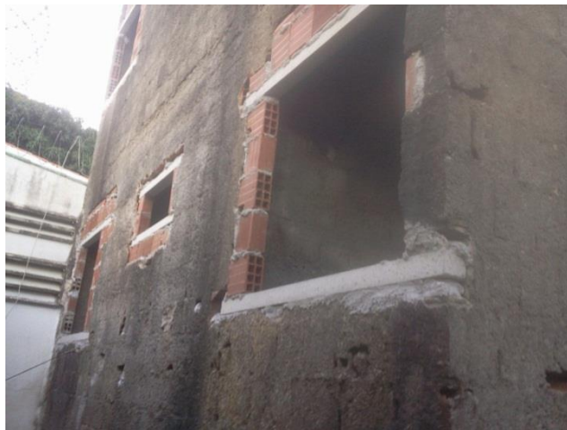
Figura 9 – Instalação de vergas e contravergas
