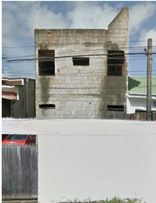
Figura 3 – Vista frontal do edifício
