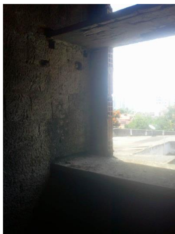
Figura 4 – Placas de concreto sob e sobre a janela
