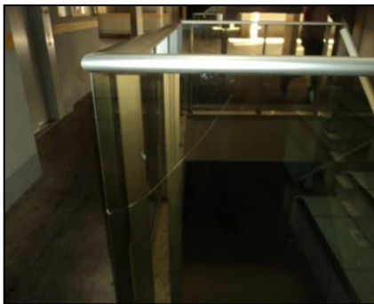
Figura 5 – (a) Trinca no Parapeito (b) Reforço Inacabado
