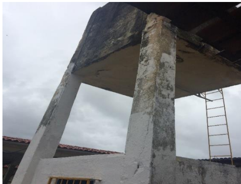
Figura 14 – Presença de mofo e bor na EREM 4
