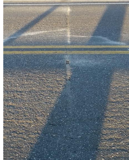
Figura 2 - Pavimento após a recuperação
