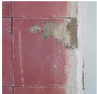
Elementos Espúrios – Agressão à estética do silhar e aos materiais do corpo cerâmico.
