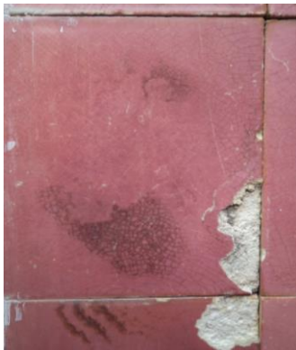
Alteração cromática – Reação química dos elementos constitutivos do azulejo ou dos vernizes de proteção.
