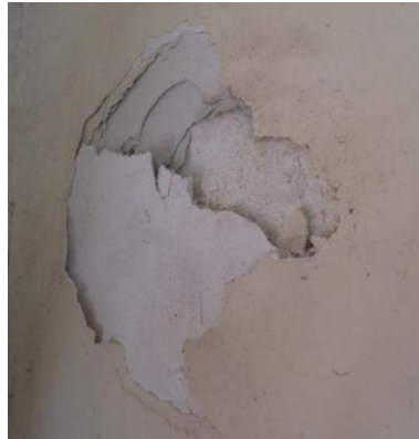
Figura 4 - Detalhe das camadas de pintura
