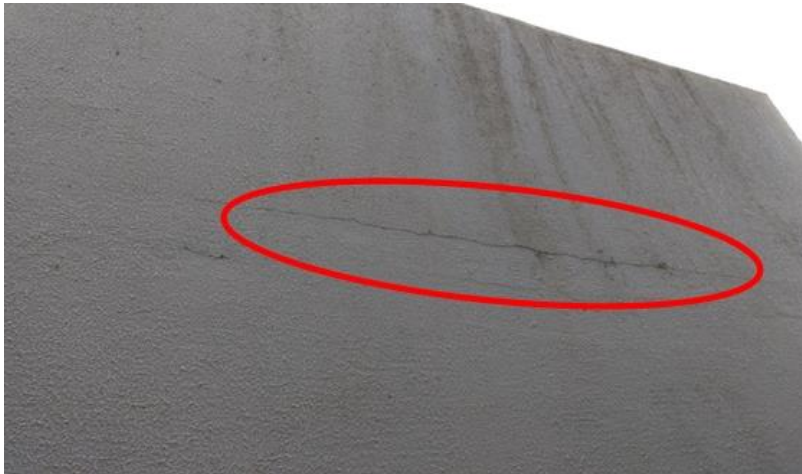
Figura 4 – Fissura horizontal
