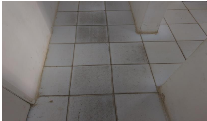
Figura 5 – Desgaste superficial
