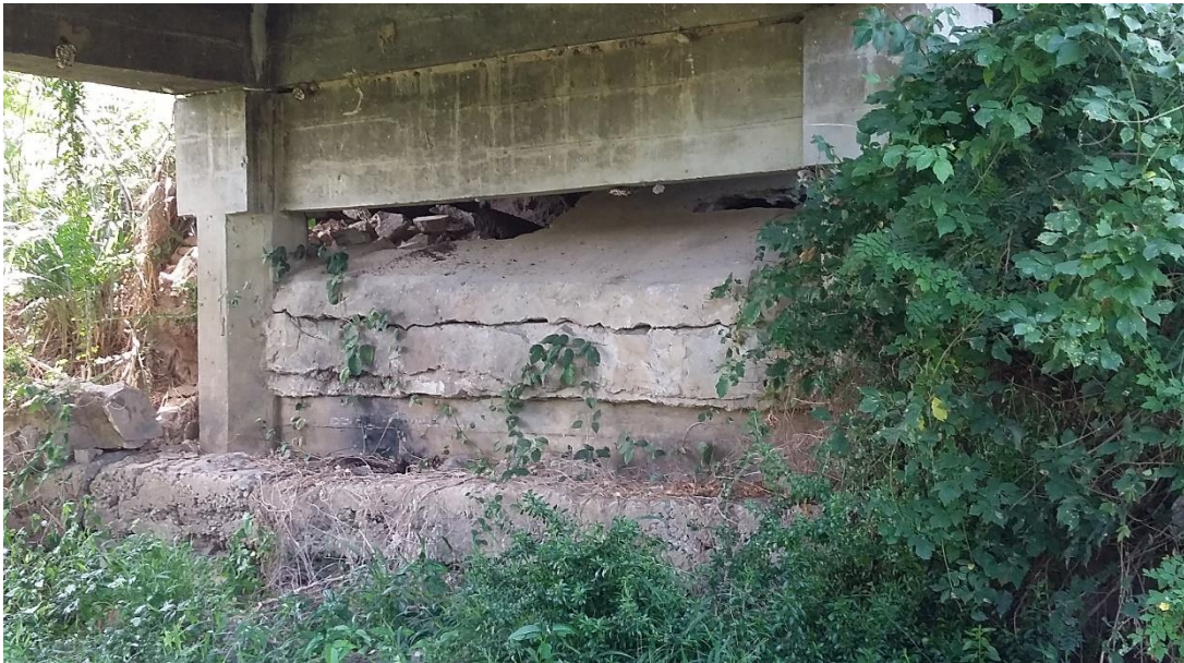
Figura 6 - Muro de contenção da parte inferior da ponte.
