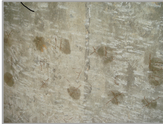
Figura 7 –Detalhe das medições do potencial de corrosão – Fonte Próprio Autor
