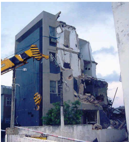
Fig. 3 – Edifício residencial- frente e parte da lateral
