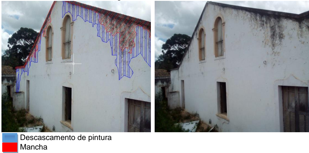
Figura 6 – Fachada lateral Casarão
