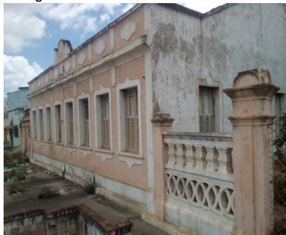
Figura 3- Fachada lateral do Casarão
