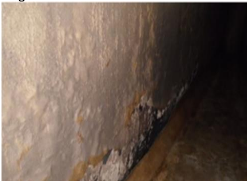
Figura 1 - Destacamento do concreto
