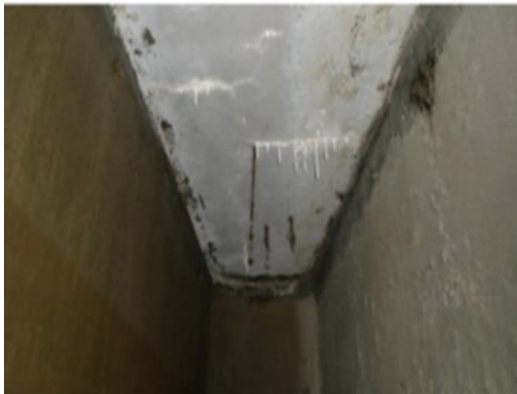
Figura 9 - Falhas de cobrimento
