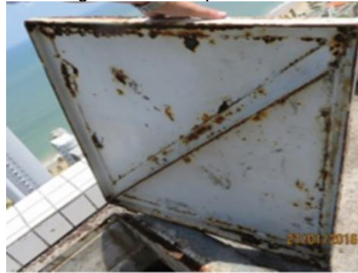
Figura 10 - Tampa corroída
