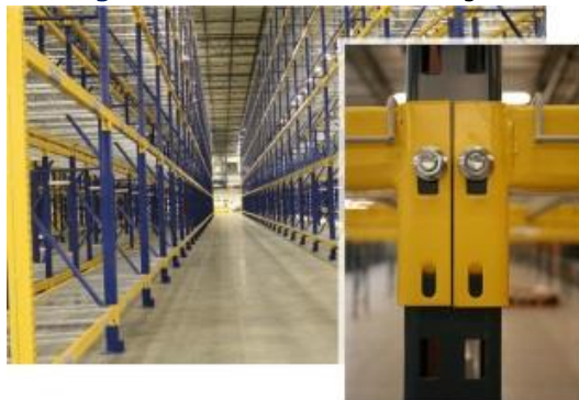
Figura 2 - Sistema de armazenagem.
