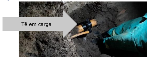
Figura 6 – Colocação da conexão de Tê em carga
