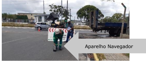
Figura 5 – Utilização do Aparelho Navegador
