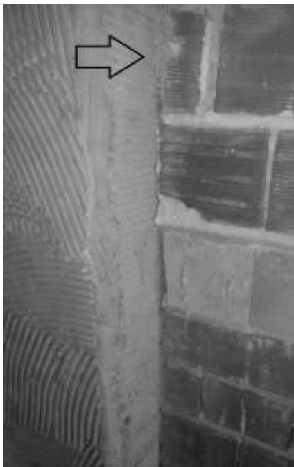
Foto 06: Telas metálicas na interface
