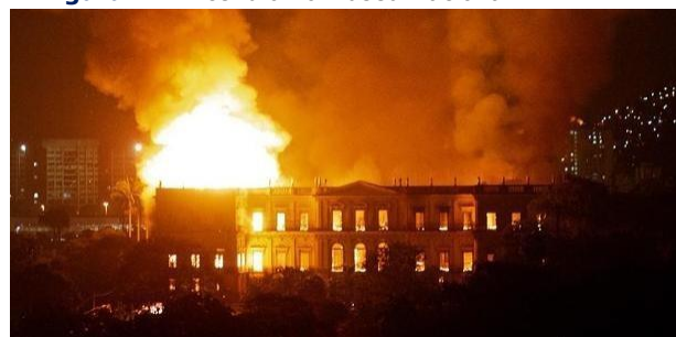
Figura 1 – Incêndio no Museu Nacional
