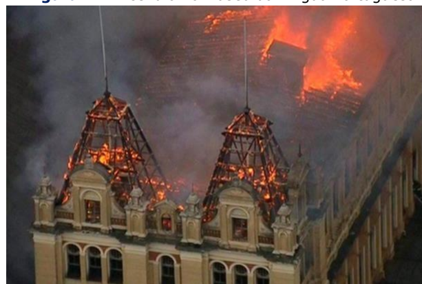
Figura 1 – Incêndio no Museu da Língua Portuguesa
