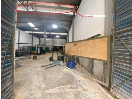
Figura 7 – Ventilação por lanternim.
