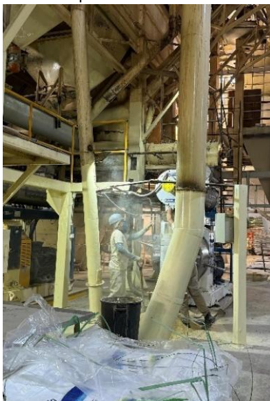
Figura 12 – Atividades operacionais na área de peletizadeira.
