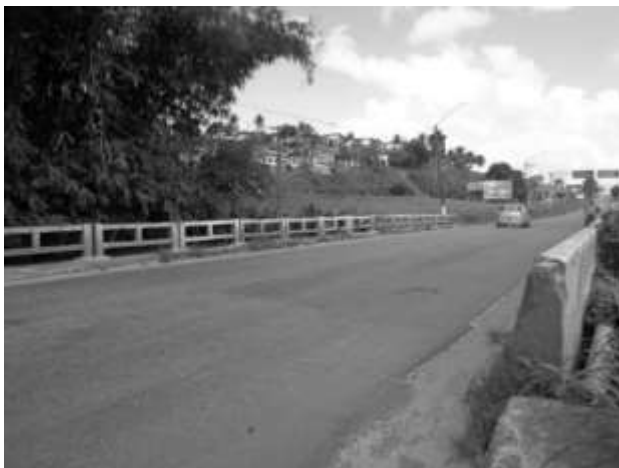
Figura 3: Vista superior da ponte
