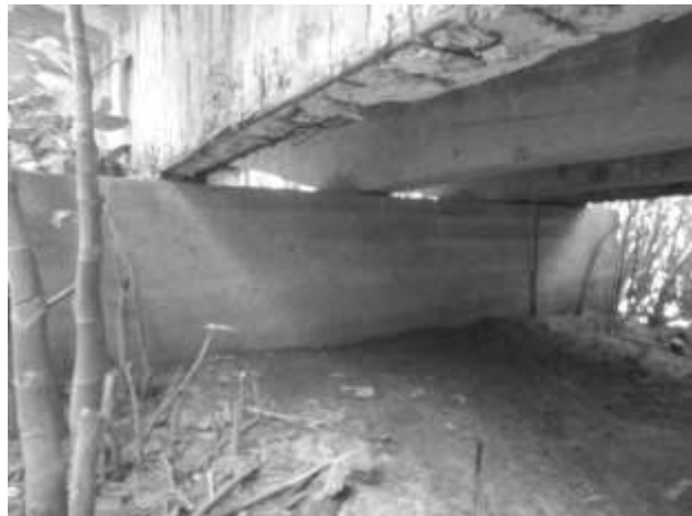
Figura 11: Pilar parede do apoio central não apresenta sinais de fissuras e deslocamentos e desaprumos
