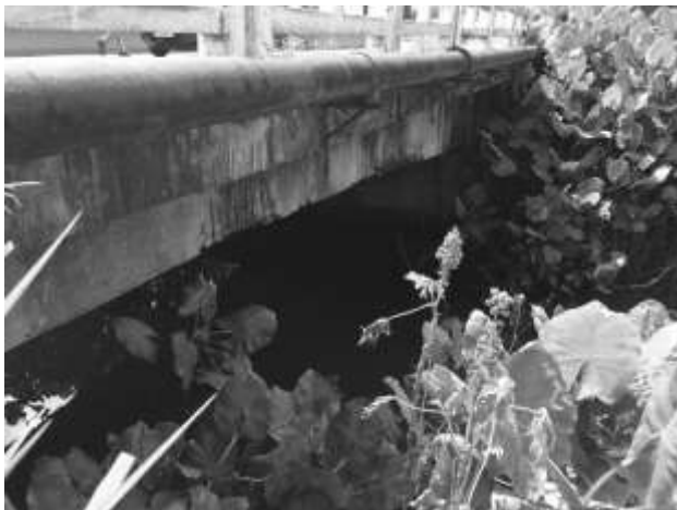
Figura 15: Fixação de tubulação por meio de chumbadores
