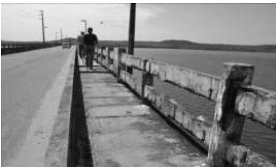
Figura 3- Detalhe do alargamento para implantação dos passeios.
