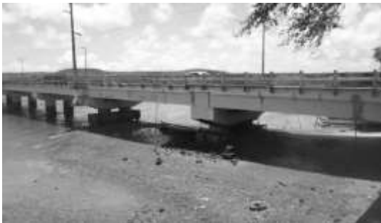
Figura 2 - Vista geral da ponte.
