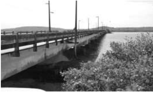
Figura 1 - Vista geral da ponte.
