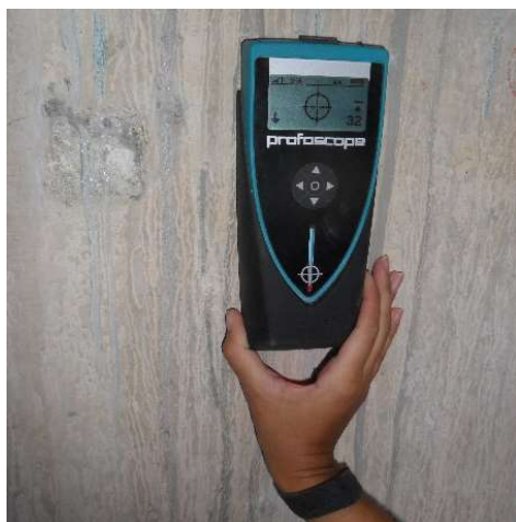
Figura 2: Localização da armadura no concreto e seu cobrimento por meio de pacometria. Fonte: Autores (2017).
