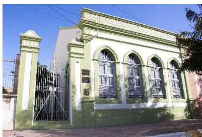
Figura 6: Fachada do imóvel nº 39. Fonte: Autores (2017).
