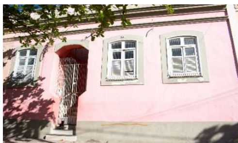
Figura 13: Fachada do imóvel nº 57. Fonte: Autores (2017).
