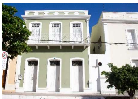
Figura 19: Fachada do imóvel nº 71. Fonte: Autores (2017).
