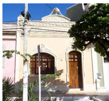
Figura 17: Fachada do imóvel nº 65. Fonte: Autores (2017).
