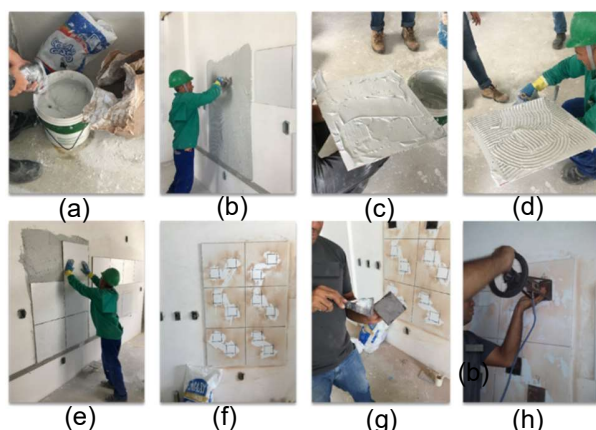
Figura 4: Ensaio com gesso-cola hidrofugante.
