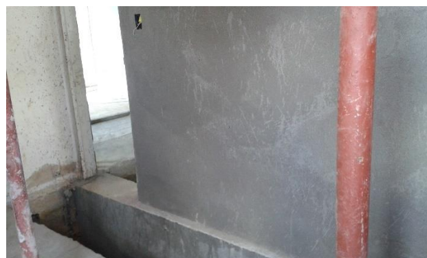
Foto 17: Alvenaria Interna Reforçada
