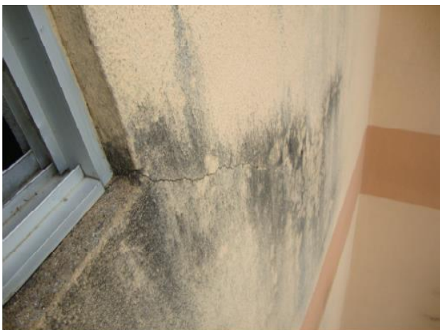
Foto 05: Ausência de Vergas e Contravergas
