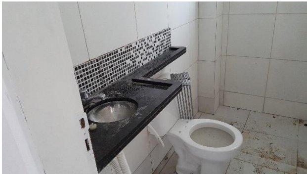
Foto 24: Interior de Imóvel Recuperado
