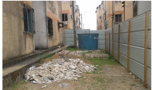
Foto 09: Retirada dos Entulhos Gerados
