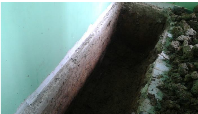
Foto 08: Exposição da Alvenaria de Embasamento
