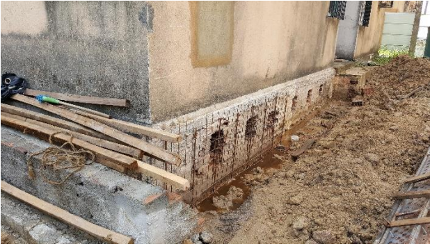
Foto 18: Reforço das Alvenarias de Periferia
