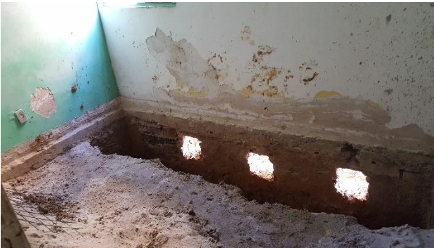
Foto 19: Reforço das Alvenarias de Periferia
