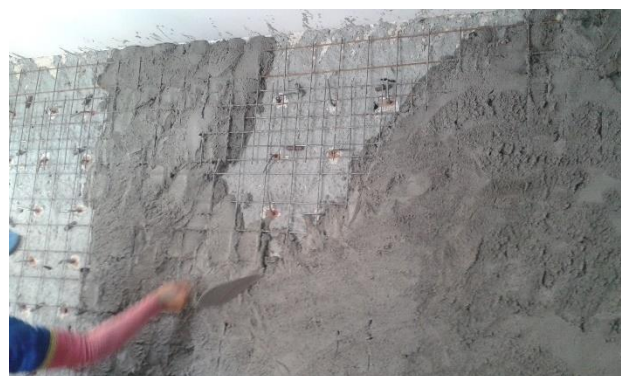
Foto 16: Aplicação da Argamassa
