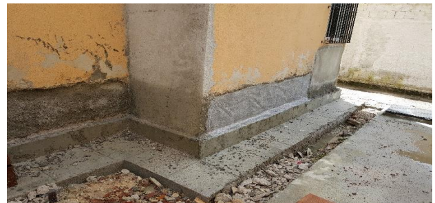
Foto 21: Recuperação das Fachadas
