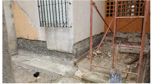
Foto 20: Recuperação das Fachadas
