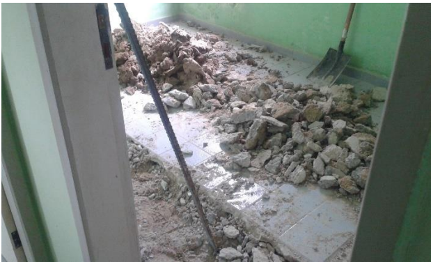
Foto 07: Remoção dos revestimentos
