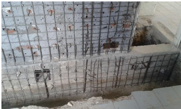
Foto 12: Montagem do reforço do embasamento
