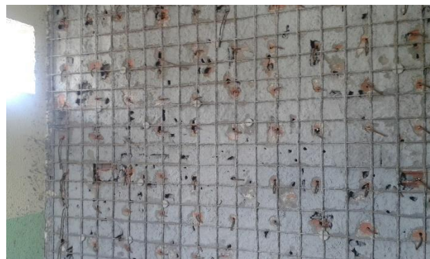
Foto 15: Reforço das Alvenarias de Elevação
