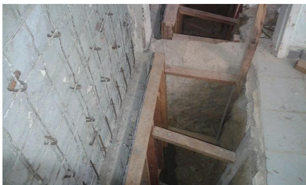
Foto 13: Preparação para concretagem
