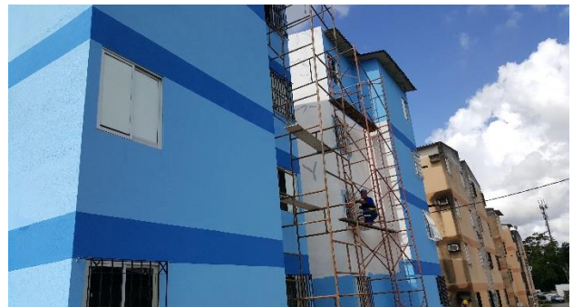
Foto 21: Recuperação das Fachadas
