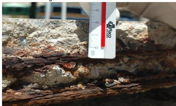
Figura 10: Medição do Recobrimento superior da peça.
