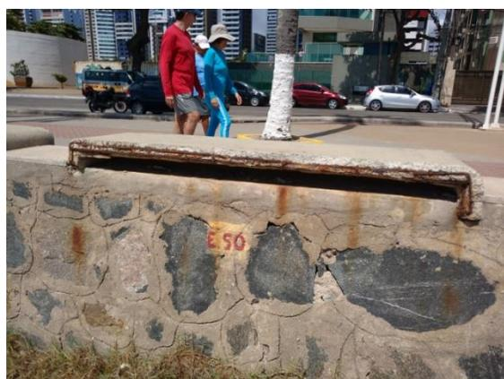
Figura 5: Evidência de corrosão em bancos adjacentes
