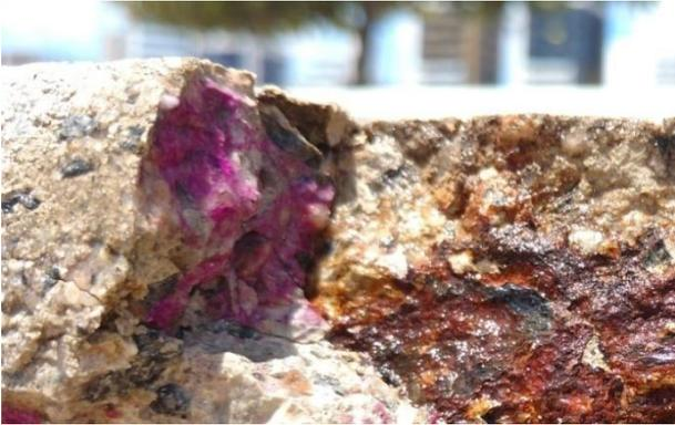
**Figura 7:** Detalhe de parte contaminada pelo dióxido de carbono.
