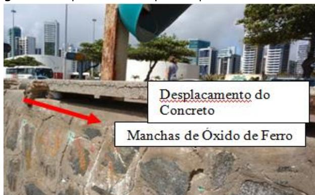
Figura 3: Deslocamento na parte de apoio do banco
