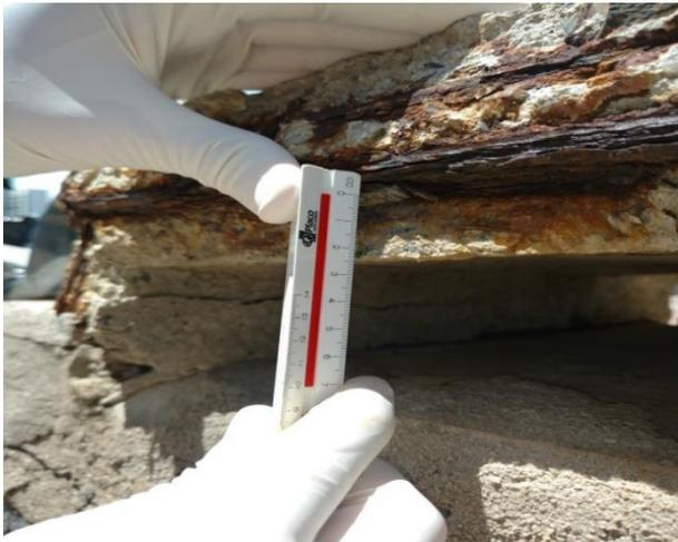
Figura 12: Medição do recobrimento de peça.
