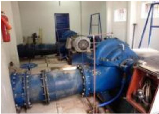
**Figura 3:** Conjuntos Motor-bomba.
