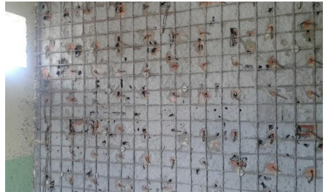
Foto 15: Reforço das Alvenarias de Elevação
