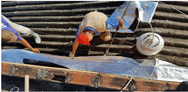
Foto 22: Recuperação da obra.
