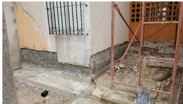
Foto 20: Recuperação das Fachadas
