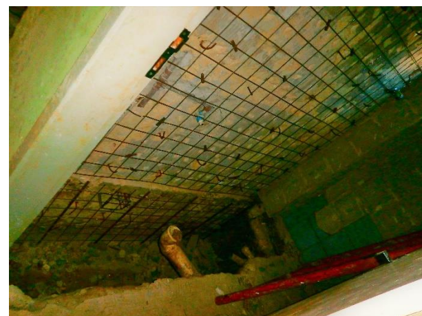
Foto 11: Recuperação das Instalações Prediais
