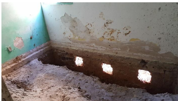
Foto 19: Reforço das Alvenarias de Periferia
