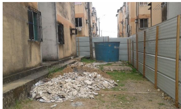
Foto 09: Retirada dos Entulhos Gerados
