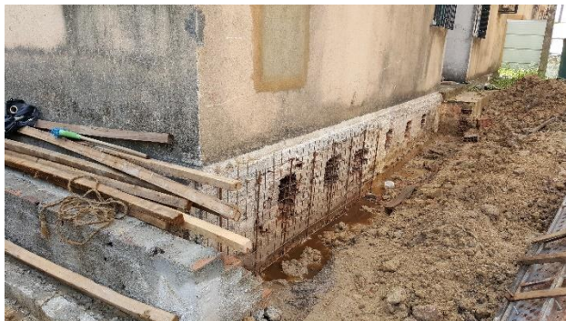
Foto 18: Reforço das Alvenarias de Periferia
