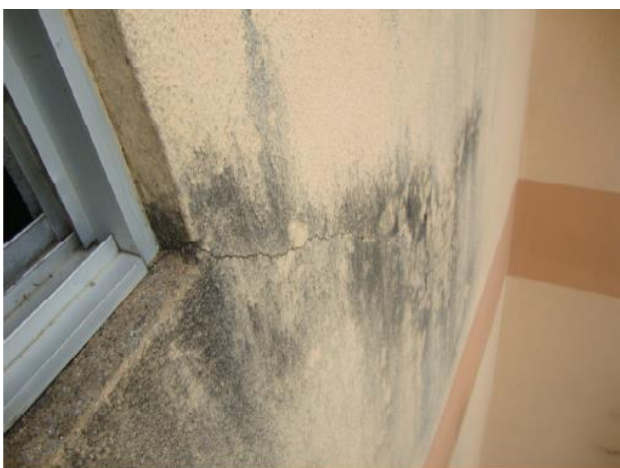
Foto 05: Ausência de Vergas e Contravergas
