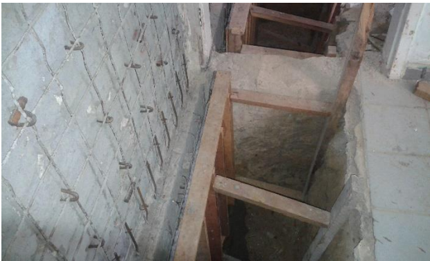
Foto 13: Preparação para concretagem
