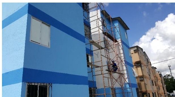
Foto 21: Recuperação das Fachadas
