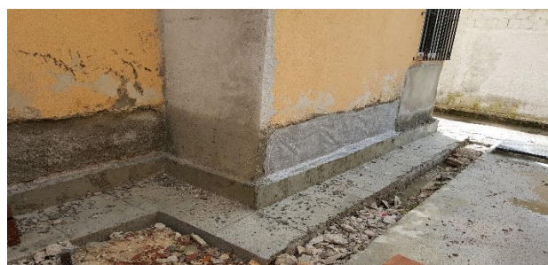
Foto 21: Recuperação das Fachadas
