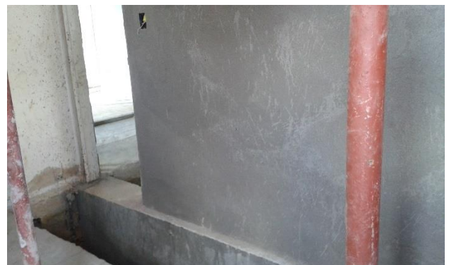
Foto 17: Alvenaria Interna Reforçada
