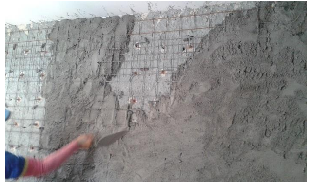
Foto 16: Aplicação da Argamassa
