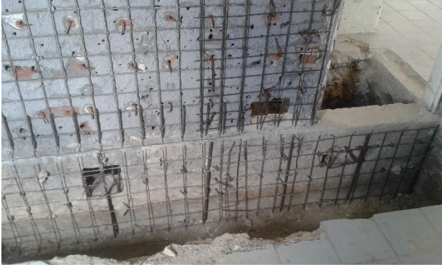
Foto 12: Montagem do reforço do embasamento
