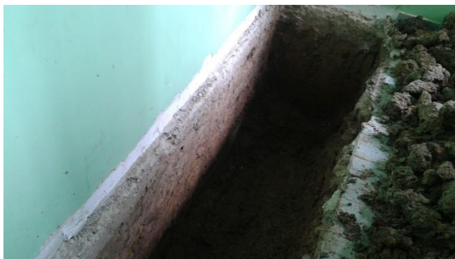
Foto 08: Exposição da Alvenaria de Embasamento
