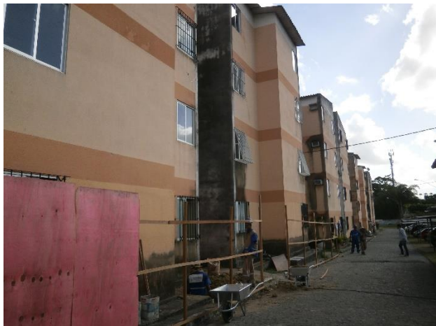
Foto 06: Montagem do Tapume
