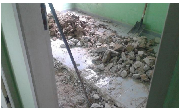
Foto 07: Remoção dos revestimentos
