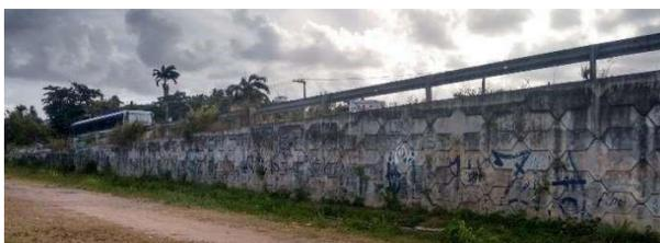
**Figura 9:** Muro de Terra Armada do viaduto Bajado.
