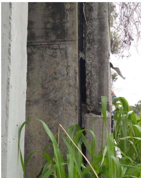
**Figura 26:** Falhas na ligação dos muros vertical e horizontal.
