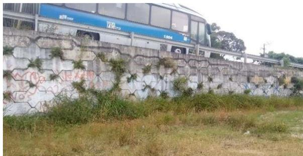
**Figura 25:** Vegetação nas juntas do muro.
