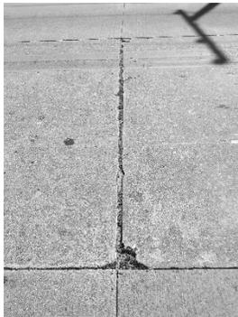
Foto 2: Falha na selagem das juntas e quebra de canto
