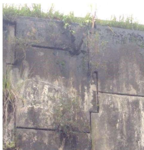
**Figura 36:** Vegetação enraizada entre as juntas das escamas.
