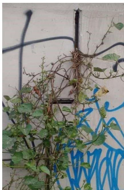
**Figura 19:** Presença de vegetação nas juntas das escamas.
