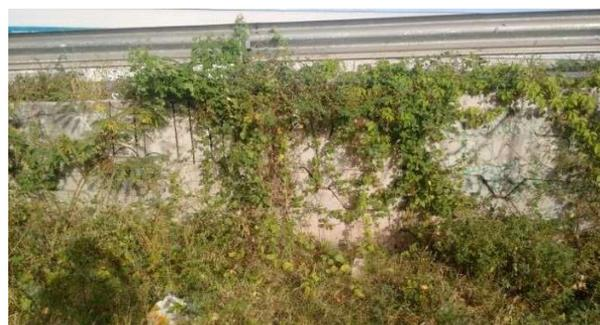
**Figura 24:** Vegetação cobrindo a terra armada.
