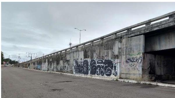
**Figura 8:** Contenção em Terra Armada do viaduto 1.
