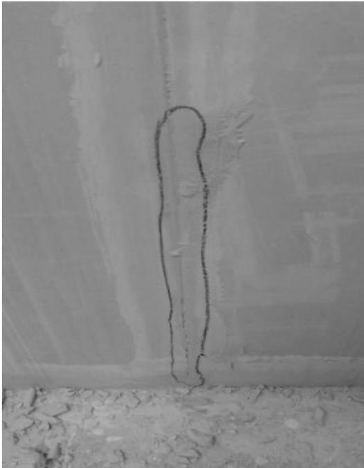
**Figura 12** - Fissura provocada por impacto de corpo mole.
