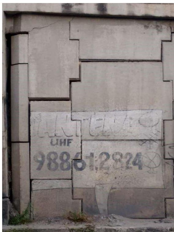
**Figura 21:** Detalhe de um desaprumo.
