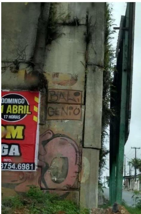
**Figura 37:** Desaprumo do muro de contenção.
