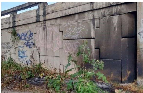
**Figura 17:** Manchas causadas pelo fogo.
