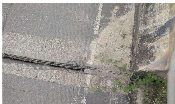
**Figura 28:** Desgaste da junta de dilatação (vista superior da junta entre o pavimento e o aterro).
