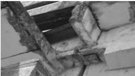
**Figura 8**- Parte inferior do passeio e console de apoio das placas pré-moldadas com estrutura em estado de degradação.
