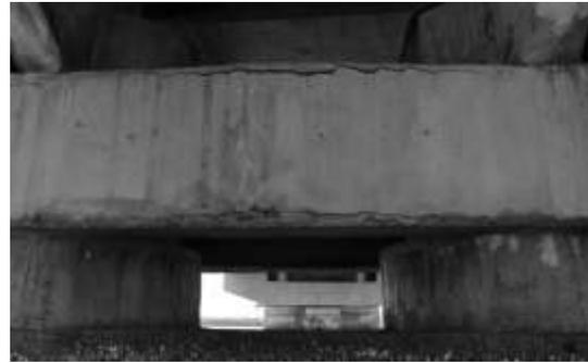
**Figura 15**- Fissuras nas travessas causadas pela expansão de armaduras.
