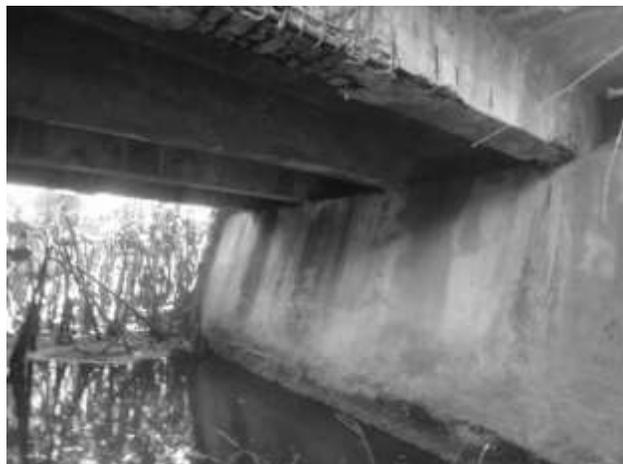
**Figura 12:** Os encontros apresentam manchas, mas não tem sinais de fissuras e deslocamentos.
