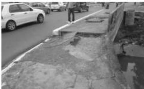
Figura 9 - Deformação do solo da passagem de pedestres.
