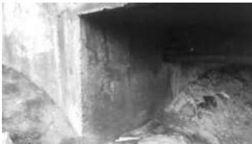
Figura 4 - Calcinação da estrutura causada por fogueiras sob a ponte.
