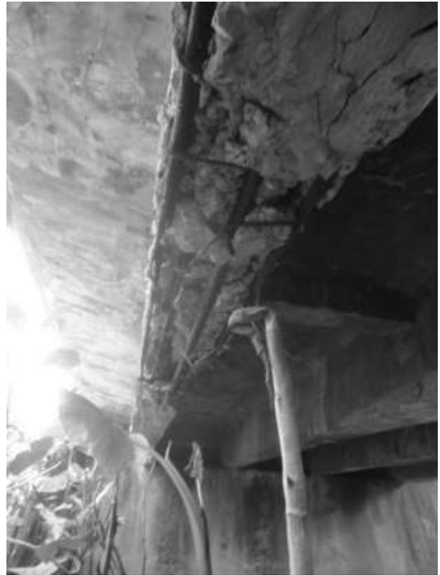
**Figura 7:** Perda total de aderência das armaduras e destruição do concreto.
