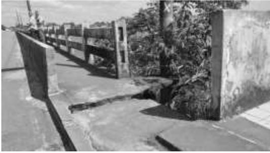
**Figura 5** - Desnível na ligação entre a ponte e o aterro, significando também uma situação de risco aos pedestres.
