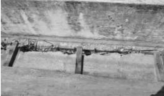
**Figura 6** - Armaduras destruídas nas placas do passeio
