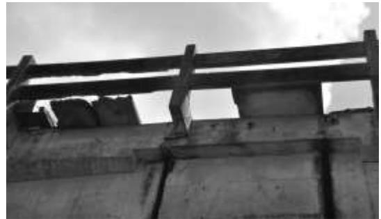
**Figura 10** - Placas pré-moldadas em balanço com estrutura completamente degradada e console comprometido.
