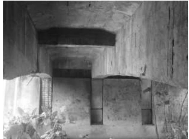
**Figura 10:** Pêndulo que apoia viga extrema com corrosão e destacamento do concreto.
