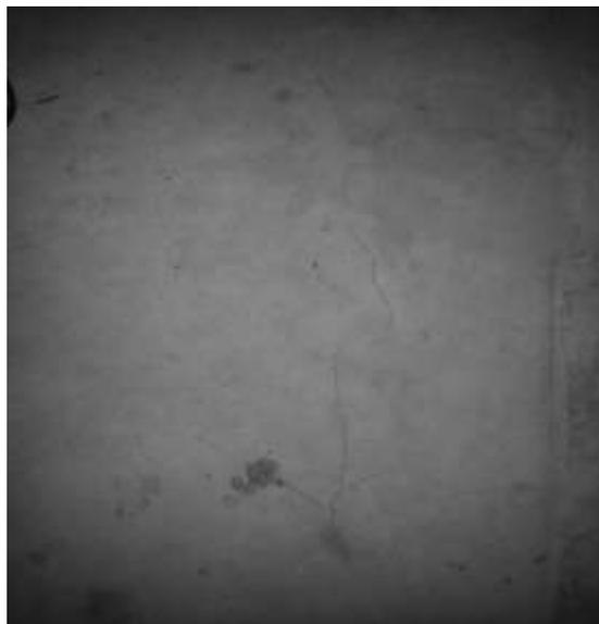
Figura 4: Retração após a fase de endurecimento do concreto.
