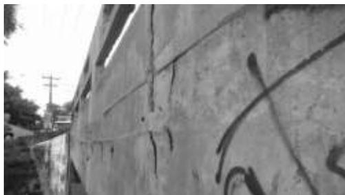
Figura 7 - Deslocamento do cobrimento do concreto que envolve a armadura lateral do tabuleiro.
