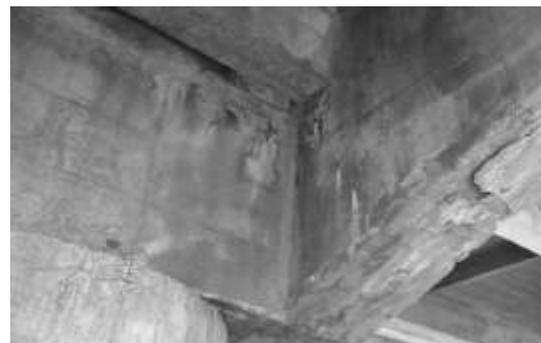
**Figura 17**- Fissuras e deslocamento do concreto nos trechos centrais das travessas
