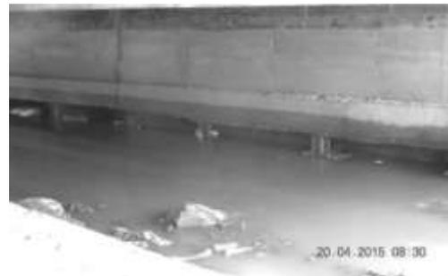
Figura 14 - Estacas metálicas expostas em área de variação de mares
