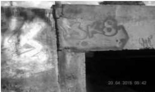
Figura 13 - Detalhe do deslocamento do tabuleiro com o encontro.
