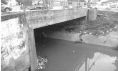
Figura 12 - Erosão no talude sob um dos lados da ponte.
