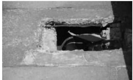
**Figura 12**- Ausência da tampa da caixa de inspeção da fiação elétrica, representando situação de risco aos pedestres.
