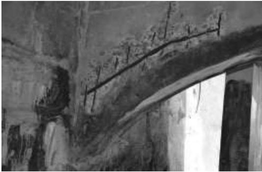
**Figura 13** - Oxidação de armaduras e deslocamento do concreto nas longarinas originais
