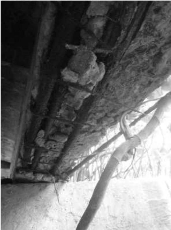
**Figura 9:** Situação da maior gravidade na face inferior de uma das longarinas extremas, com destruição total das armaduras e do concreto.
