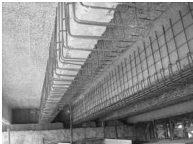
Figura 16: Exemplo de alargamento e reforço de uma ponte antiga com o uso de concreto armado convencional.
