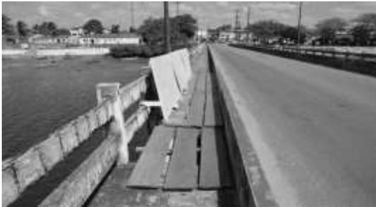
**Figura 7**- Tábuas no passeio, assentadas em substituição às placas e guarda-corpos destruídos, caracterizando situação de alto risco para os pedestres.
