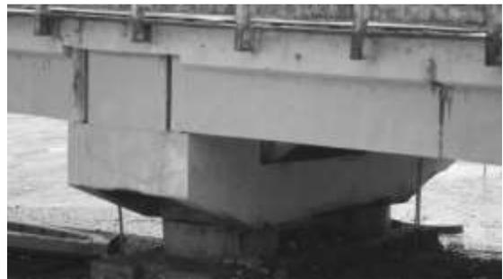
**Figura 11**- Vista lateral do console e bloco de coroamento.
