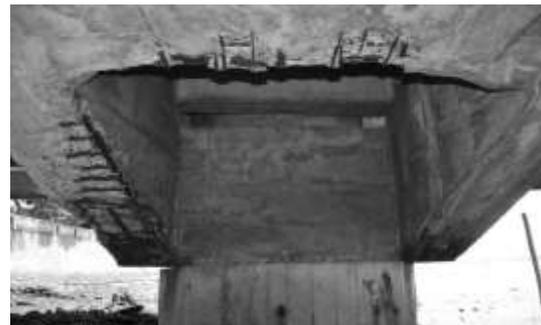
**Figura 16**- Travessas de apoio dos passeios de pedestres, com avançado estado de corrosão de armaduras e deslocamento do concreto.
