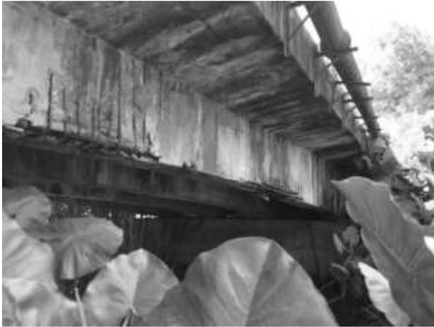
**Figura 5:** Ausência de pingadeira, contribuindo para o aparecimento de manchas no concreto e de corrosão nas armaduras
