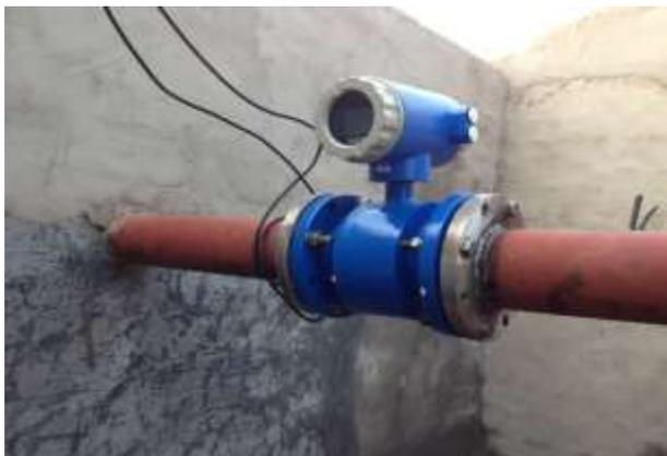
**Figura 3:** medidor de vazão eletromagnético versão compacta instalado – Fonte: <https://sanisoluti.com.br/>
