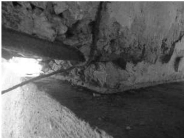
**Figura 13:** Detalhe do apoio central das longarinas, presumindo ser do tipo chapa de chumbo ou a inexistência de aparelho de apoio.
