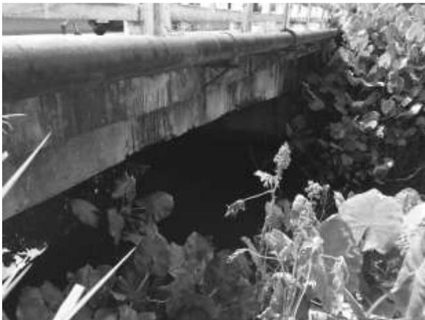
Figura 15: Fixação de tubulação por meio de chumbadores
