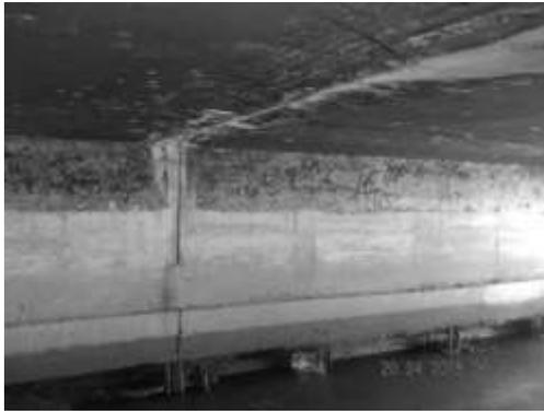
Figura 3 - Formação de bolor e mofo na laje do tabuleiro.
