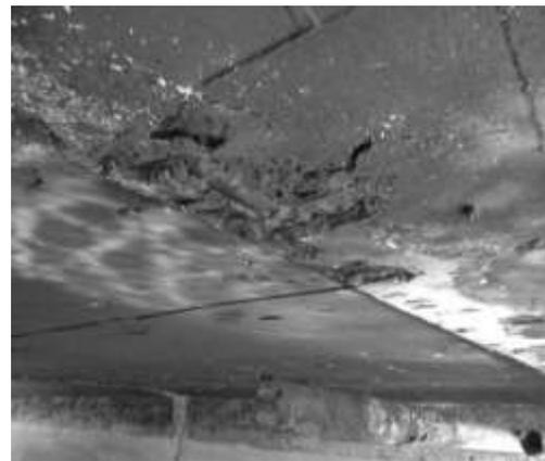
Figura 6 - Falhas de concretagem oriundas de má execução da vibração do concreto.
