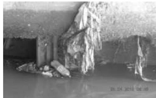
Figura 15 - Estacas metálicas com grande acúmulo de lixo.
