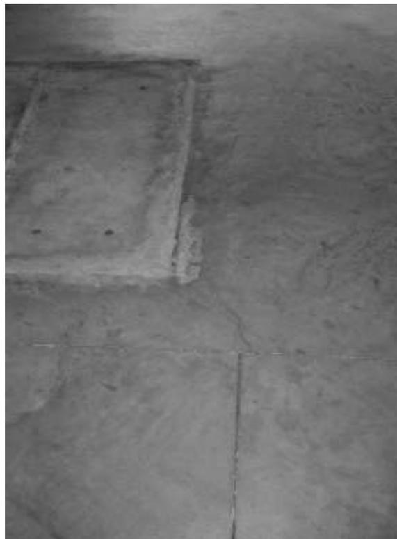
**Figura 10:** Fissura a partir de quinas reentrantes.
