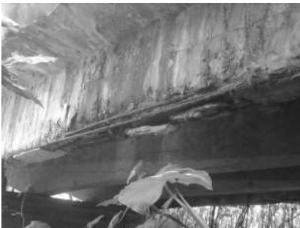
**Figura 6:** Vista de uma longarina extrema, mostrando as armaduras de flexão sem aderência e estribos destruídos.
