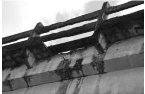
**Figura 9**- Parte inferior do guarda-corpo e console em avançado estado de deterioração.
