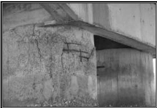
**Figura 18-** Grandes fissuras, corrosão de armaduras e sinais de lixiviação nos pilares.
