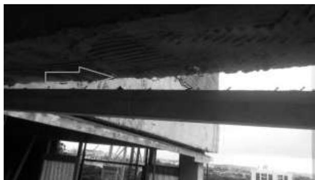
Foto 07: Telas metálicas para auxiliar no encunhamento
