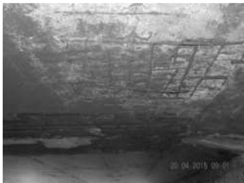
Figura 8 - Baixa espessura da camada de cobrimento da armadura, causando a exposição das mesmas.
