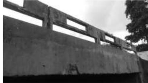
Figura 5 - Ausência de pingadeiras na borda da laje do tabuleiro da ponte.
