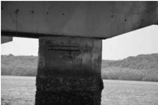
**Figura 14**- Oxidação de armaduras de pilares em estado avançado, com deslocamento do concreto. Grande incrustação de moluscos no trecho de variação da maré
