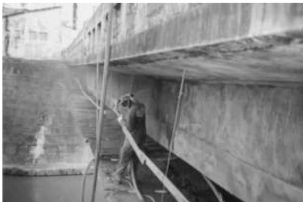
**Figura 17:** Exemplo da aplicação de concreto projetado no reforço das longarinas de uma ponte.
