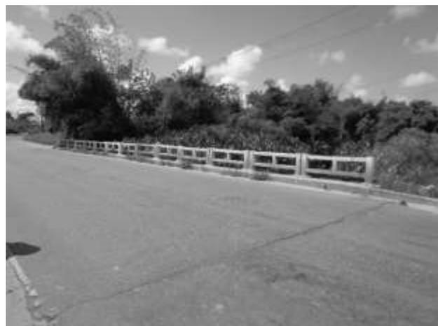
Figura 4: Ausência de junta e de passeios
