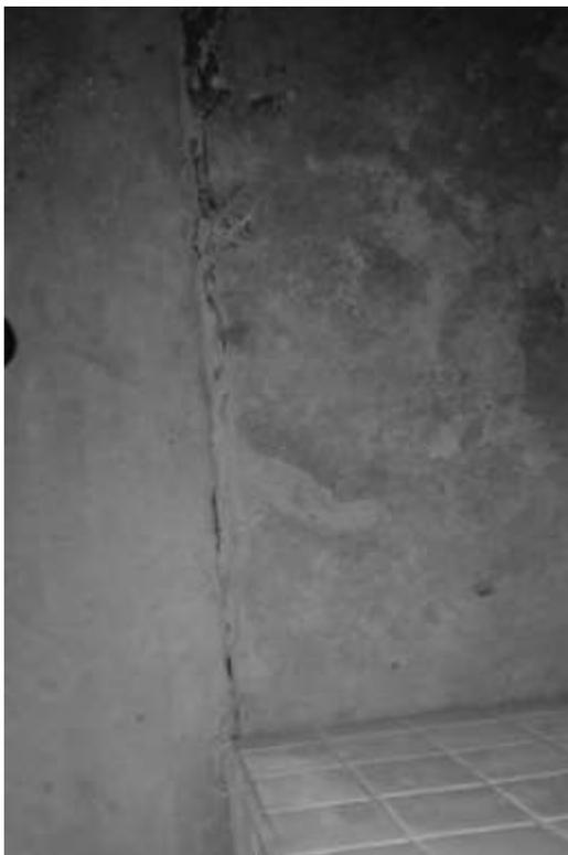
**Figura 9:** Diferença de nível entre duas placas.
