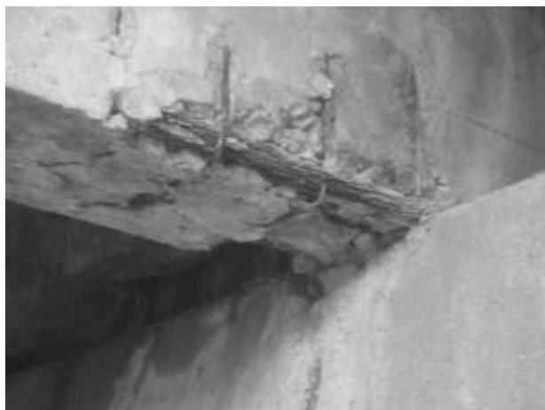
**Figura 14:** Detalhe do apoio da longarina sobre o encontro do lado oposto aos pêndulos, indicando tratar-se de chapas de chumbo ou a ausência de aparelhos de apoio pela destruição por esmagamento do concreto em zona de compressão.
