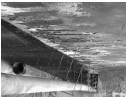
Figura 11 - Tubulações fixadas inadequadamente no tabuleiro da ponte.
