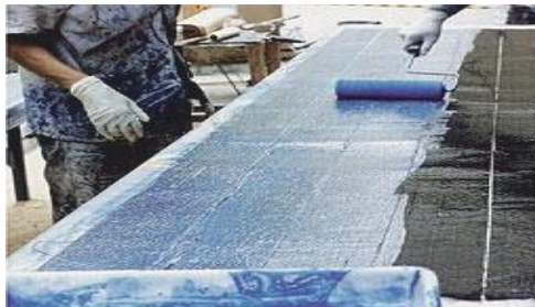
Figura 9: Imprimação da fibra de carbono na bancada.
