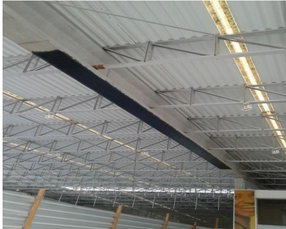
Figura 11: Aplicação do compósito CFC na viga central conforme projeto estrutural
