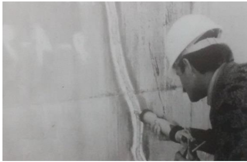
Figura 7: Injeção de fissuras.
