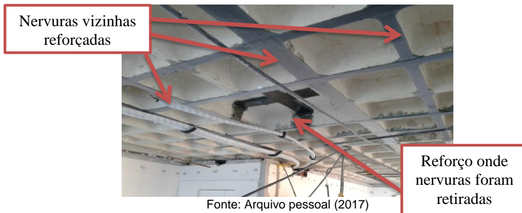
Figura 14: Aplicação do CFC nas nervuras vizinhas ao local onde houve o corte e na laje onde as nervuras foram cortadas.
