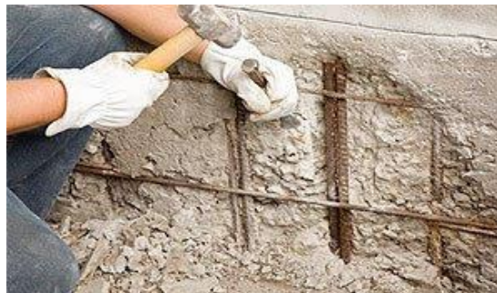
Figura 6: Remoção do concreto deteriorado.
