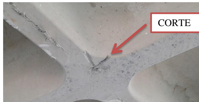
Figura 13: Irregularidades contidas na superfície de concreto e marcação do corte da nervura.
