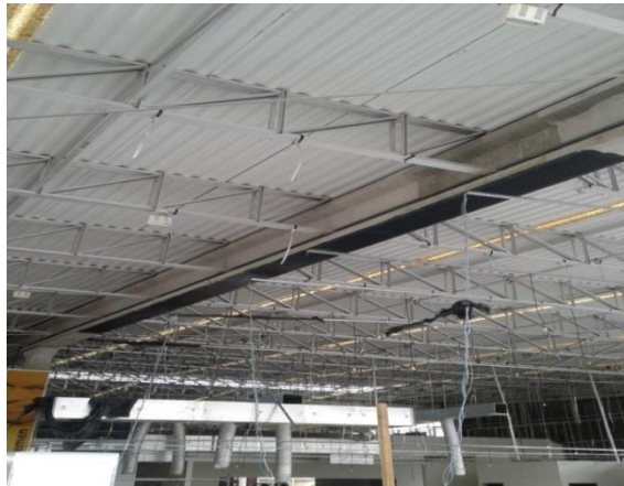
Figura 12: Instalação dos tirantes após aplicação do reforço na viga central
