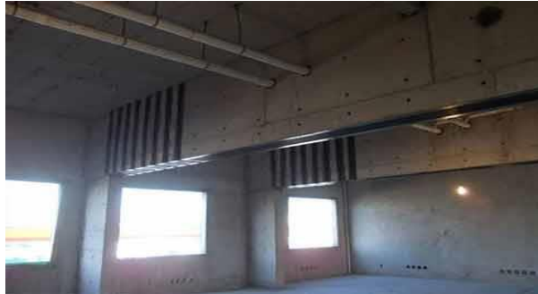
Figura 3: Reforço de viga a flexão e ao cisalhamento com fibras de carbono.
