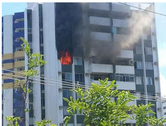
Figura 4-Incêndio no apartamento com reflexos no apartamento superior e inferior
