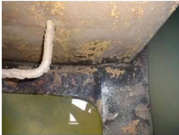
Figura 13 – Impermeabilização deficiente.
