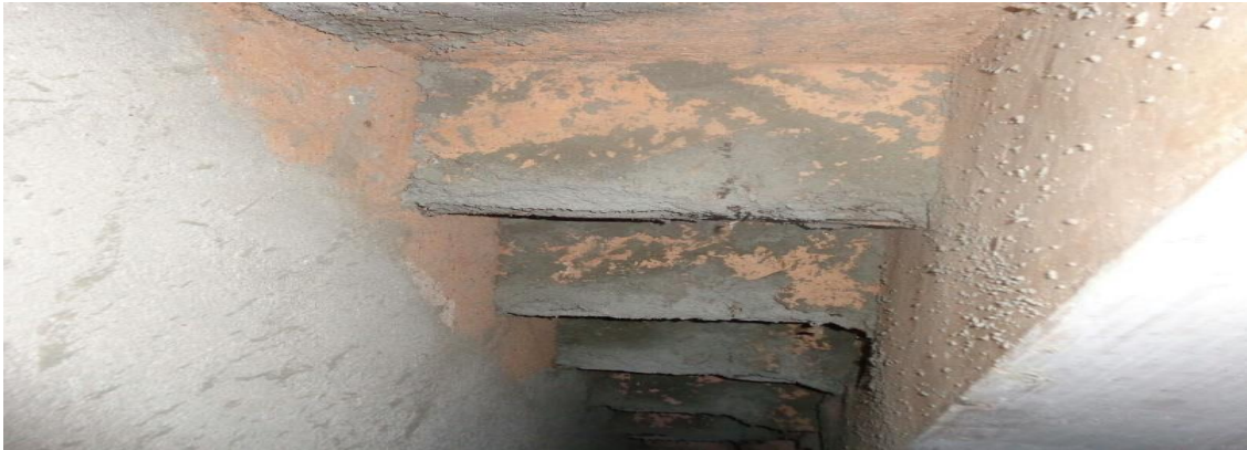
Figura 4 - Escada no início do processo de restauração.
