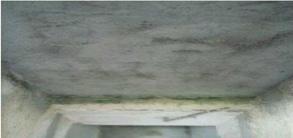
Figura 8 - Reparo da laje.
