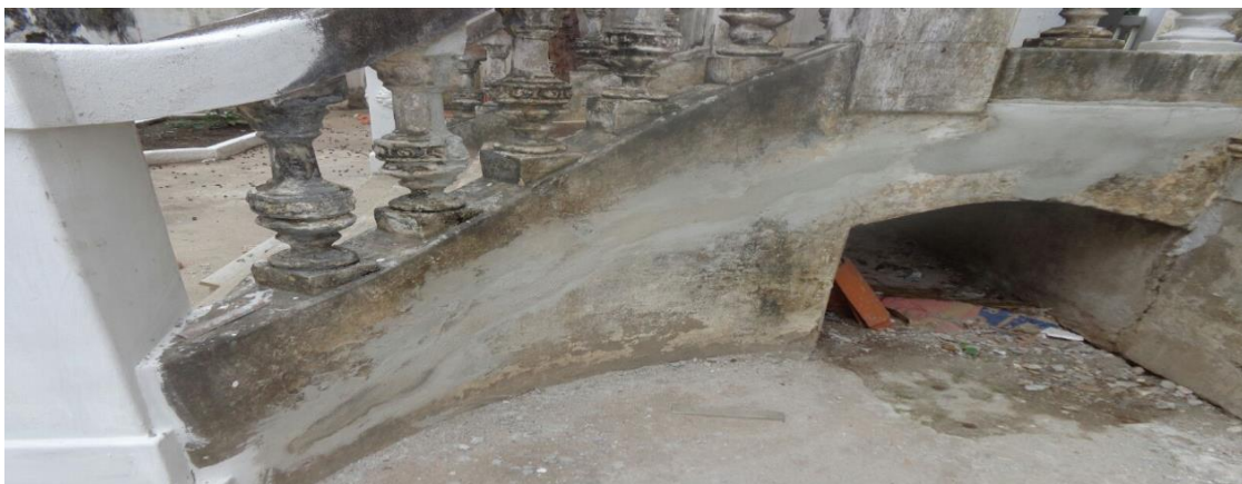
Figura 10- Reparo da lateral da escada.
