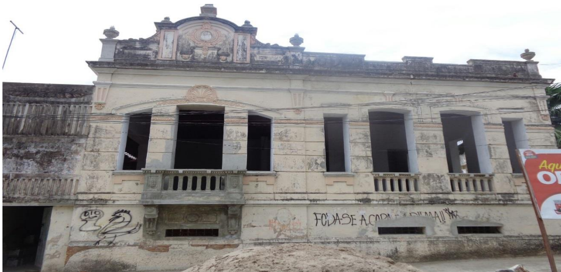
Figura 2 – Fachada frontal da edificação objeto do estudo.
