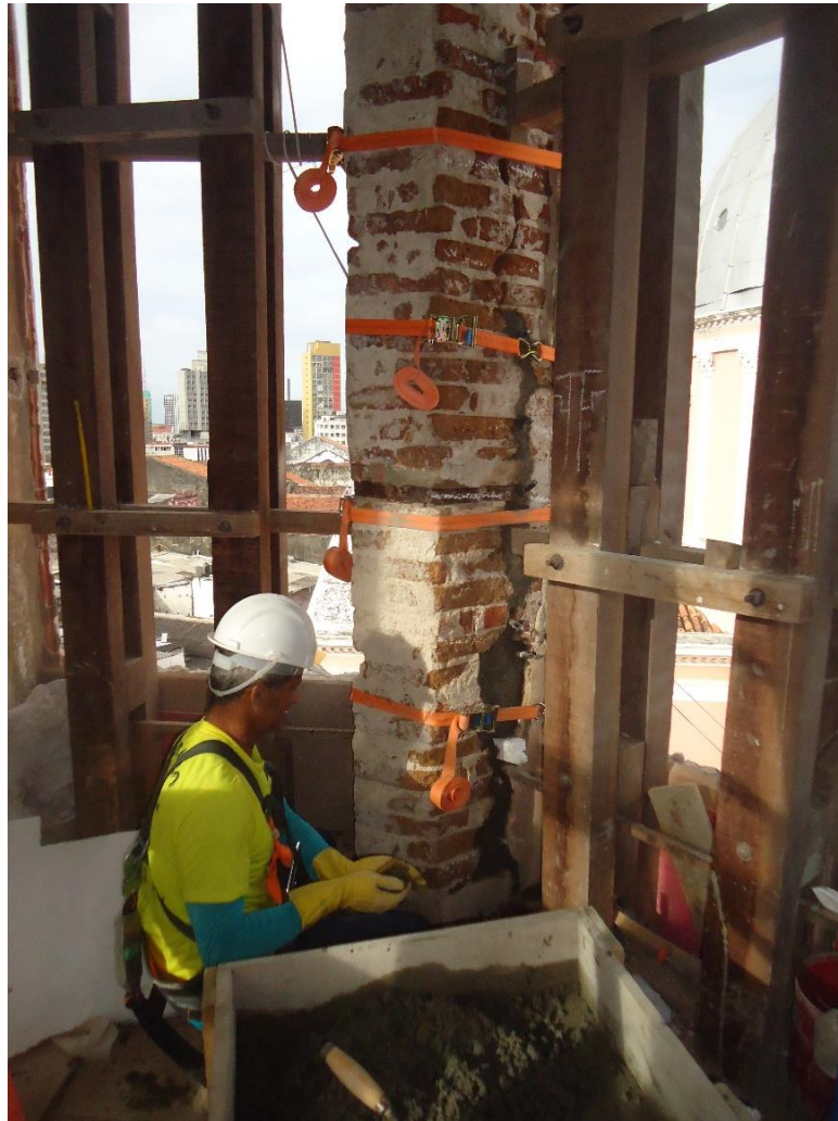
Figura 7- Aplicação Manual do Graute Tix
