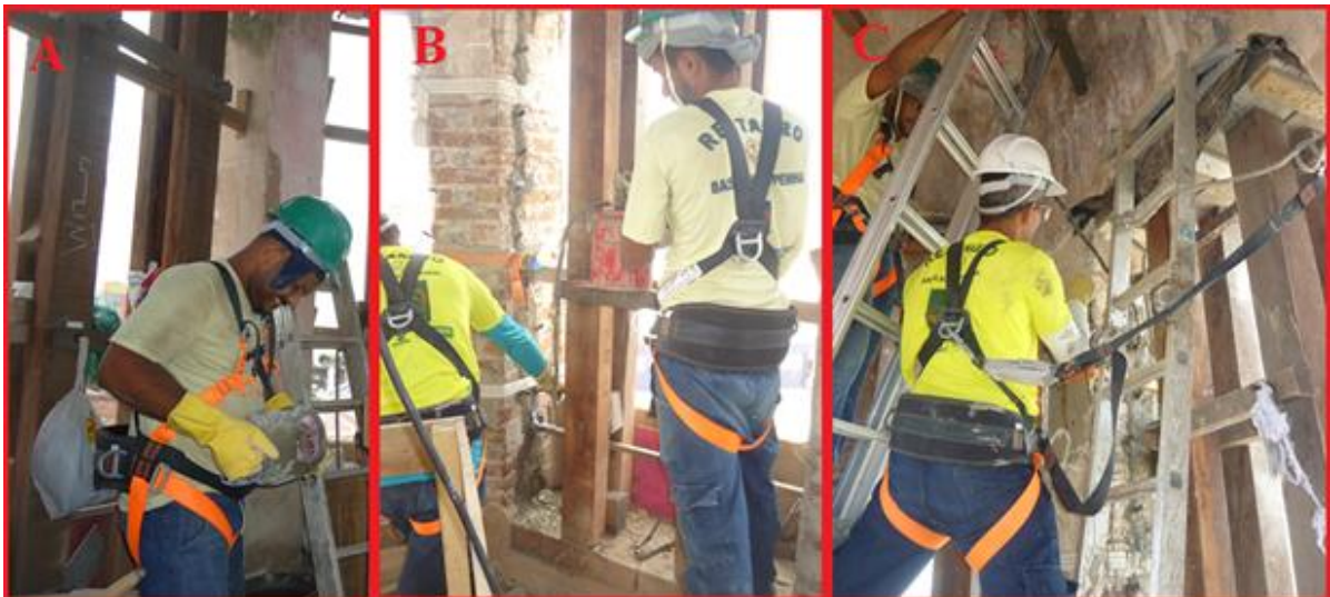
Figura 8- A- Mistura em um botijão de água para obter a pasta de cimento; B- Injeção da Pasta de Cimento no Ponto Mais Baixo do Purgador; C- Injeção da Pasta de Cimento no Ponto Mais Alto do Purgador.
