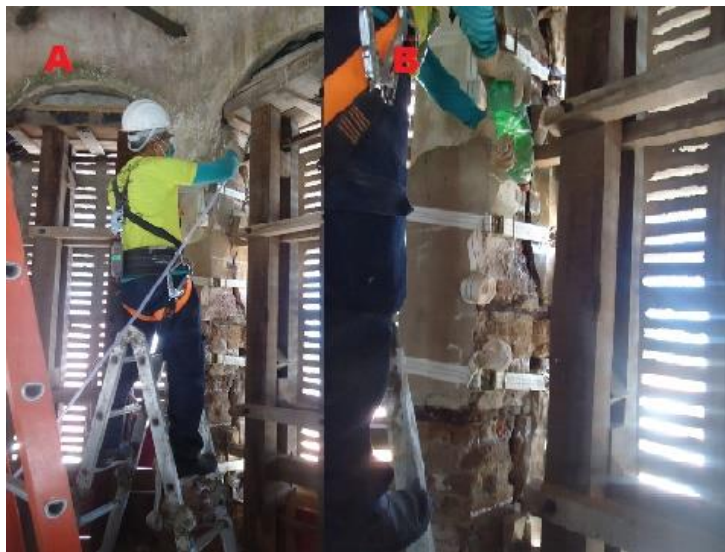
Figura 6 - A- Limpeza com Jato de Ar para a Remoção da Poeira; B - Umidificação para Aplicação do Graute.
