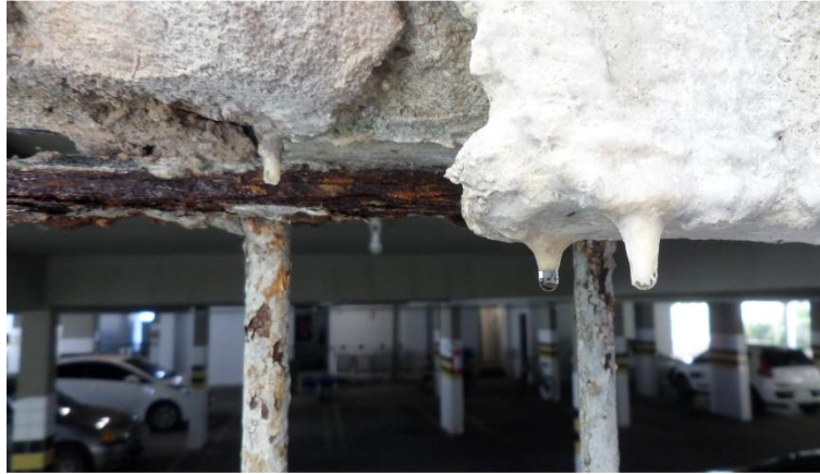
Figura 9 – Formação de estalactite em viga sob a churrasqueira
