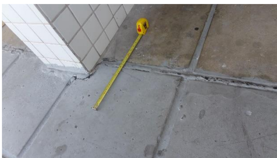
Figura 10 – Juntas estruturais da laje do pilotis e pintura impermeabilizante nas áreas externas
