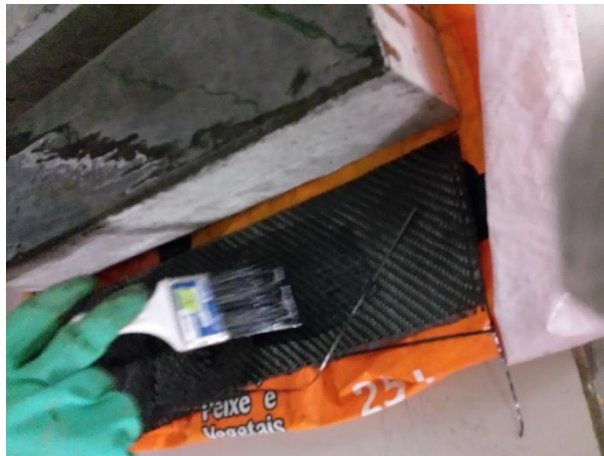
Figura 7 Imprimação da Resina epóxi na Fibra de carbono
