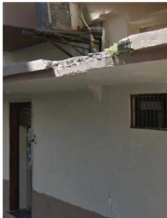
Figura 5: Deterioração da marquise.
