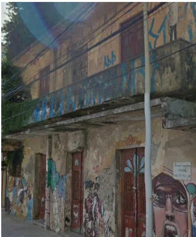
Figura 6: Vista da fachada.
