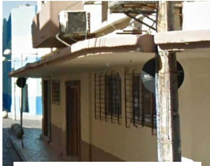
Figura 5: Deterioração da marquise.
