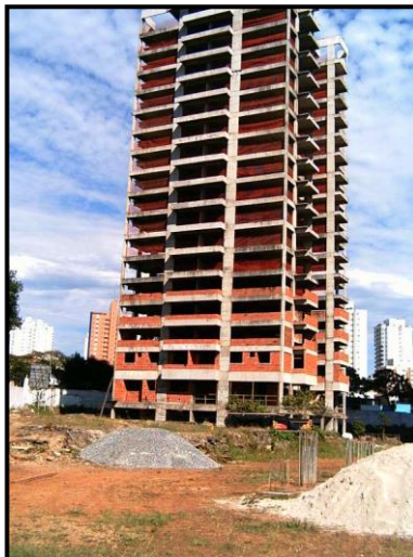
Foto 1 - Vista de obra paralisada com estrutura à vista
