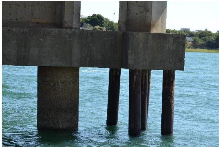
Figura 10 – Vista dos elementos de fundação em concreto armado e aço
