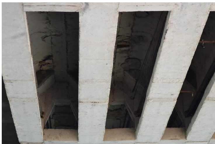
Figura 3 – Vista de outra parte do tabuleiro da ponte
