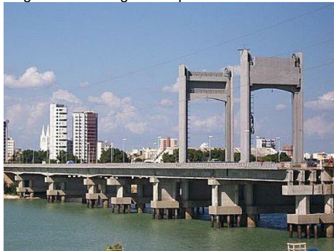
Figura 1 – Vista geral da ponte Presidente Dutra
