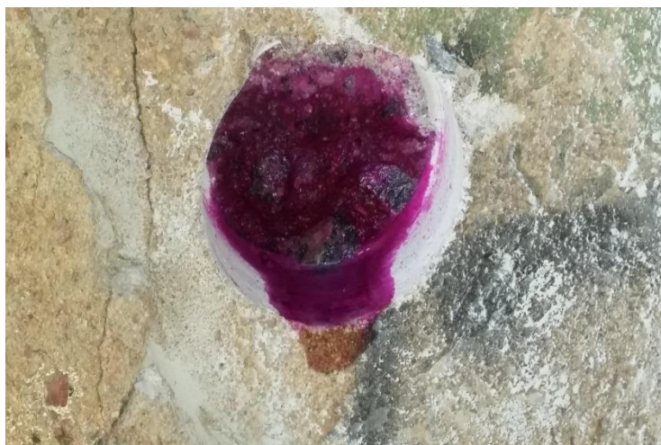
Figura 16 – Detalhe do ensaio no bloco de fundação sem indicio de carbonatação
