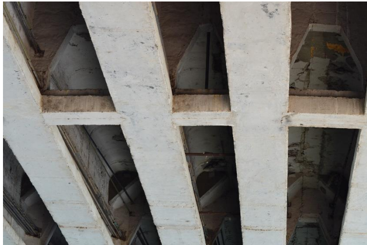
Figura 2 – Vista da parte inferior do tabuleiro da ponte
