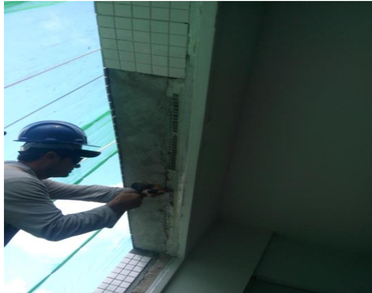
Figura 3- Demolição do emboço antigo
