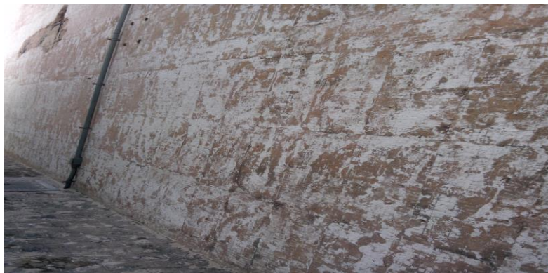
Figura 2- Demolição do revestimento antigo
