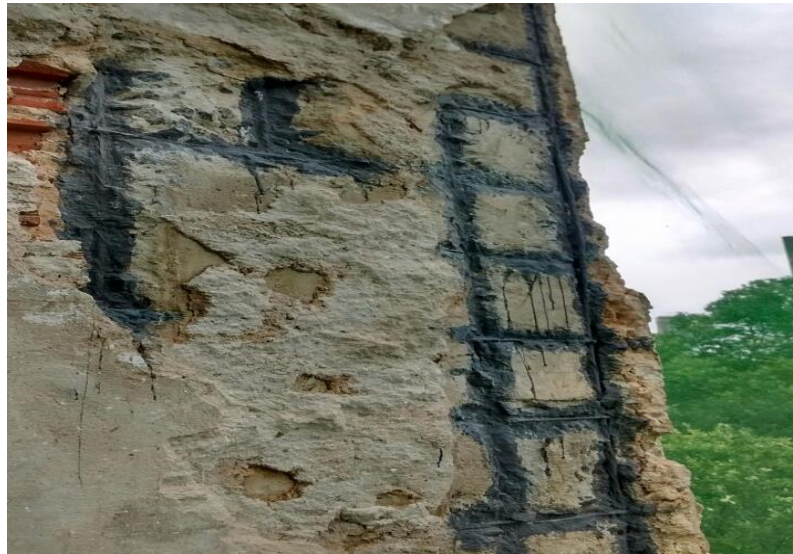
Figura 5 - Tratamento da armadura
