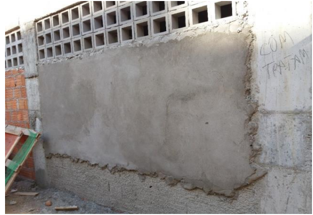
Figura 5: Emboço aplicado. Fonte: Autor.
