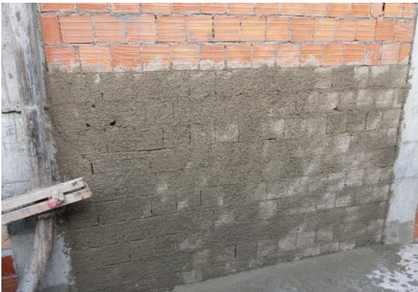
Figura 4: Alvenaria chapiscada. Fonte: Autor.
