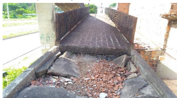
Figura 13: Rampa de acesso da passarela.
