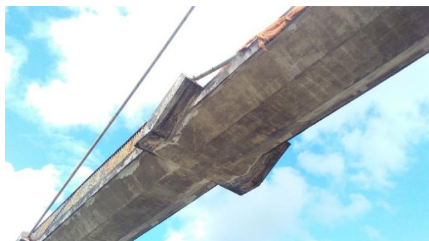
Figura 11: Parte inferior do tabuleiro da passarela.
