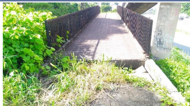
Figura 12: Rampa de acesso da passarela.
