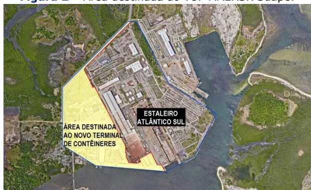
Figura 2 – Área destinada ao TUP MAERSK Suape.
