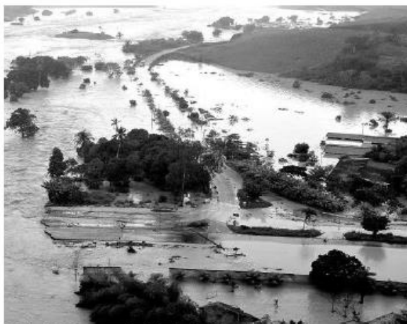
Fig. 04. Acesso à cidade de Água Preta, interrompido pela cheia de junho/2010. Fonte: Secretaria Estadual de Imprensa.
