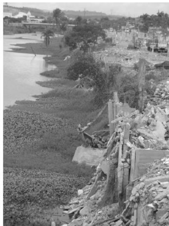
Fig. 14. Desobstrução das margens do rio Uma Fonte: CODECIPE
