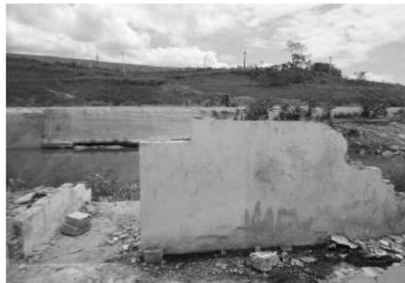
Fig. 17. Ruínas de residências e BR 101 (ao fundo), as margens do Rio Una. Fonte: Silva ( 2010 )
