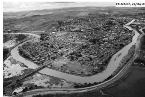
Fig.11. Ocupação urbana as margens do rio.
