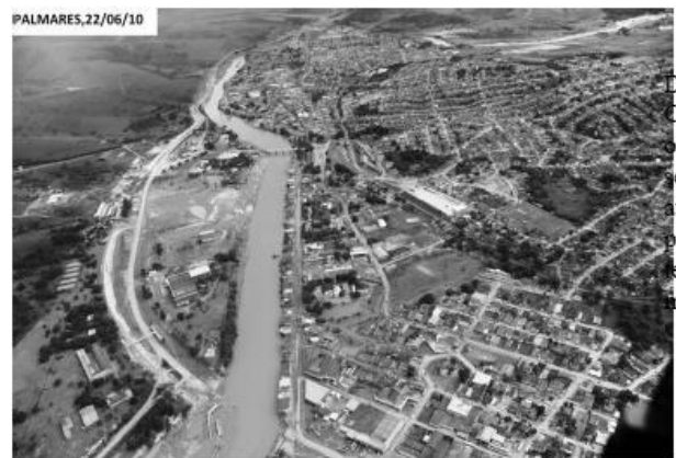
Fig.12. Ocupação urbana as margens do rio.
