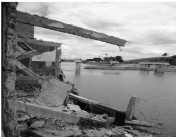
Fig. 15. Prédios as margens do Rio Una destruídos pela cheia de 2010, na área de acesso à cidade. Fonte: Silva ( 2010 )
