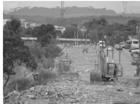
Fig. 13. Desobstrução das margens do rio Uma Fonte: CODECIPE
