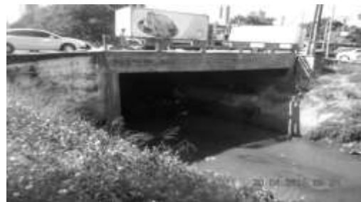
Figura 1 - Vista lateral da ponte.
