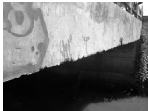
Figura 2 - Detalhe da espessura lateral da laje.
