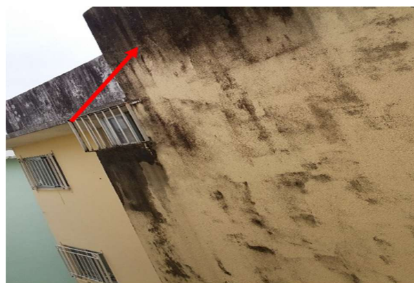
Figura 2: Fachada oeste de uma edificação do condomínio B
