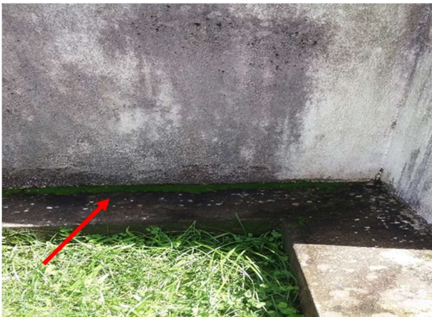
Figura 4: Fachada oeste de uma edificação do condomínio A
