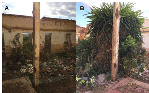
Figura 2: Pilares P1 (A) e P2 (B).
