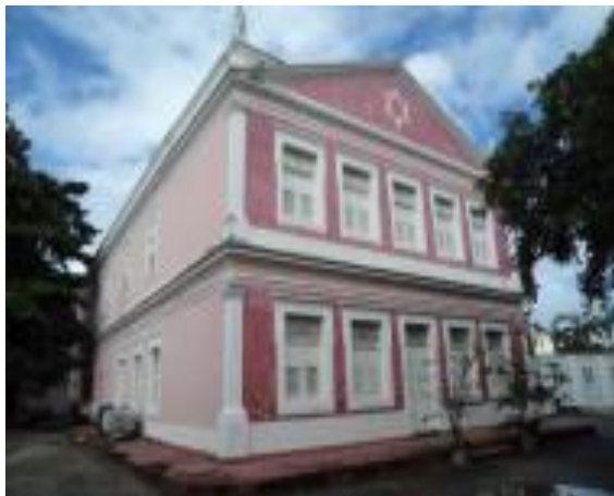
Figura 3: Bloco A – fachada atual
