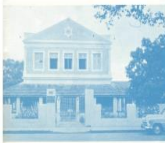
Figura 2: Bloco A – fachada original. Fonte: [14].
