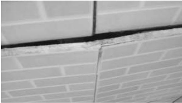
**Figura 7 :** Descolamento de cerâmica no pavimento superior da edificação.
