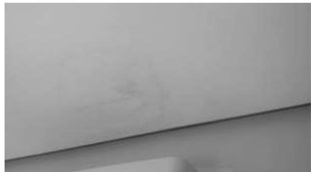
Figura 3 : Mancha de infiltração. (Fonte: Autor)
