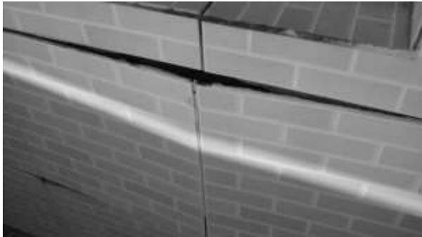
**Figura 8 :** Descolamento de cerâmica no pavimento superior da edificação.
