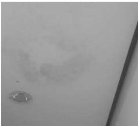
**Figura 4 :** Manchas de infiltração e aparecimento de bolor.
