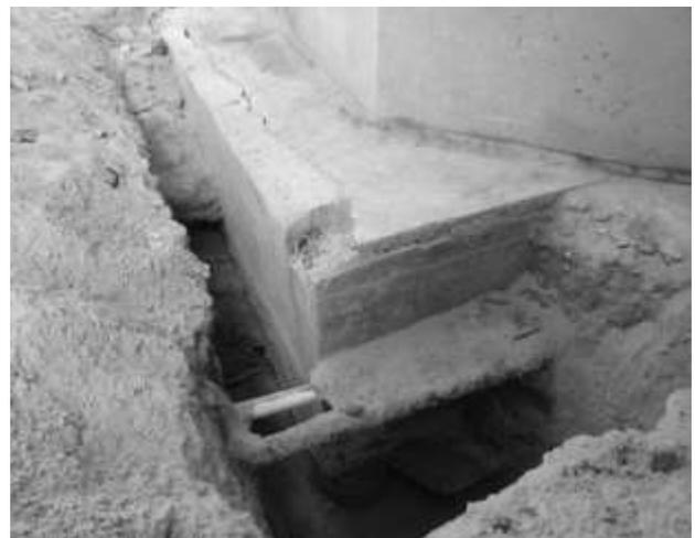
Figura 3: Fissuras concentradas na parte superior do bloco
