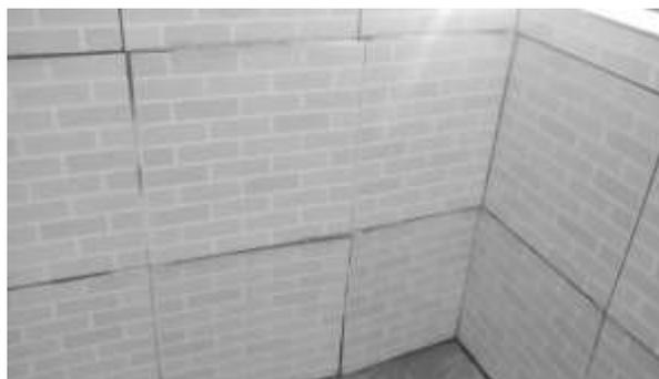
**Figura 6 :** Descolamento de cerâmica no pavimento superior da edificação.
