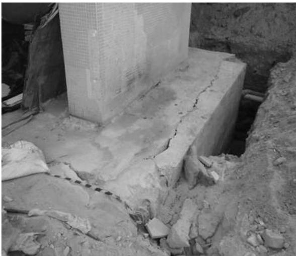
Figura 2: Fissuras na parte superior do bloco
