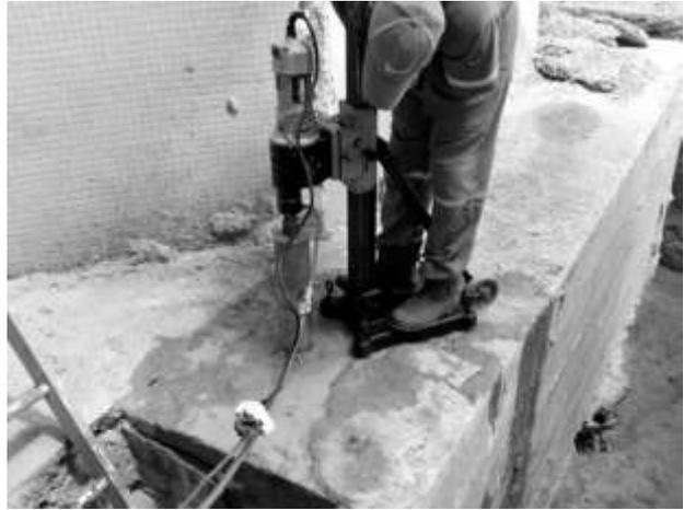
Figura 6: Retirada de testemunho para avaliação da qualidade do concreto
