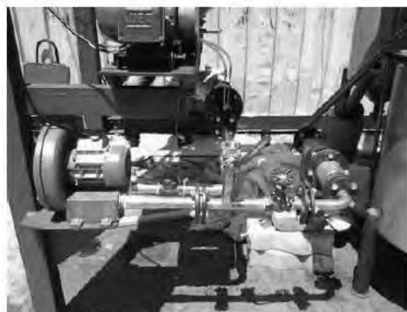
Figura 17. Tubulações antigas a montante e a jusante do soprador.
