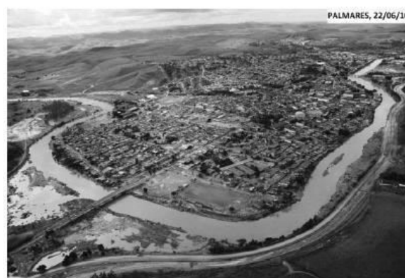
Fig.11. Ocupação urbana as margens do rio. Fonte: CODECIPE
