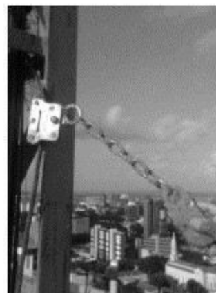
Fig 7. Dispositivo trava-quedas.
