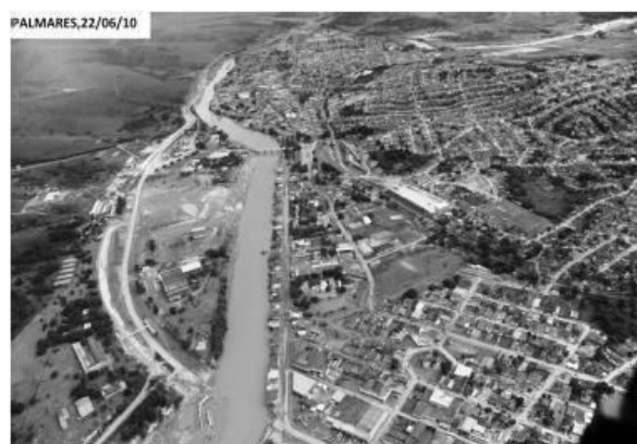
Fig.12. Ocupação urbana as margens do rio. Fonte: CODECIPE
